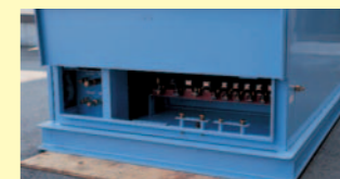
一次側キャブタイヤ取付部
