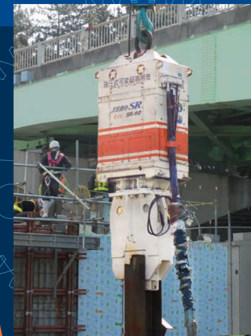
工事名:和歌山下津港海岸(海南地区) 零の浦水門取付護岸築造等工事 杭規格:H350(L=36.5m) 発注:国土交通省
