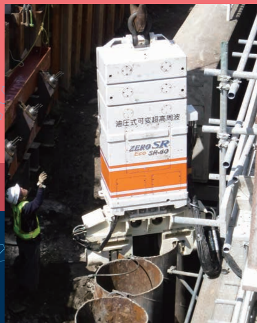
工事名:横浜市湘南道路引地川改良工事(引抜き) 杭規格:鋼管矢板Φ1100(L=15m) 発注:国土交通省
