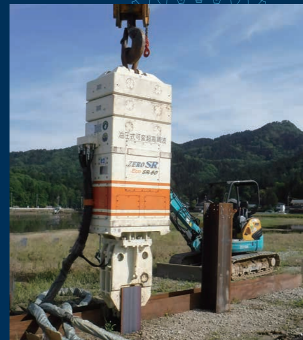
工事名:北陸新幹線福井橋りょう他 杭規格:H350(L=23.0m) 施工現場:福井県福井市
